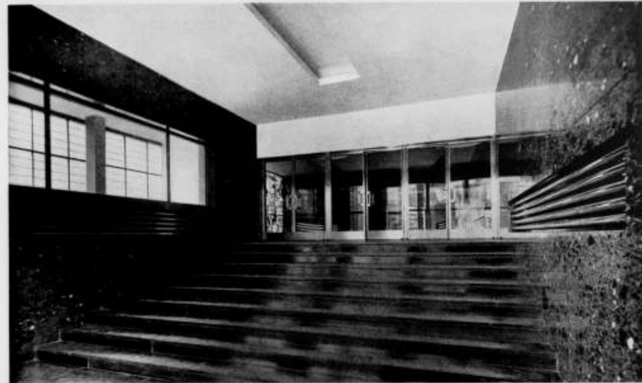
GEBOUW RHENANIA OSSAG (SHELLHAUS), BERLIJN
