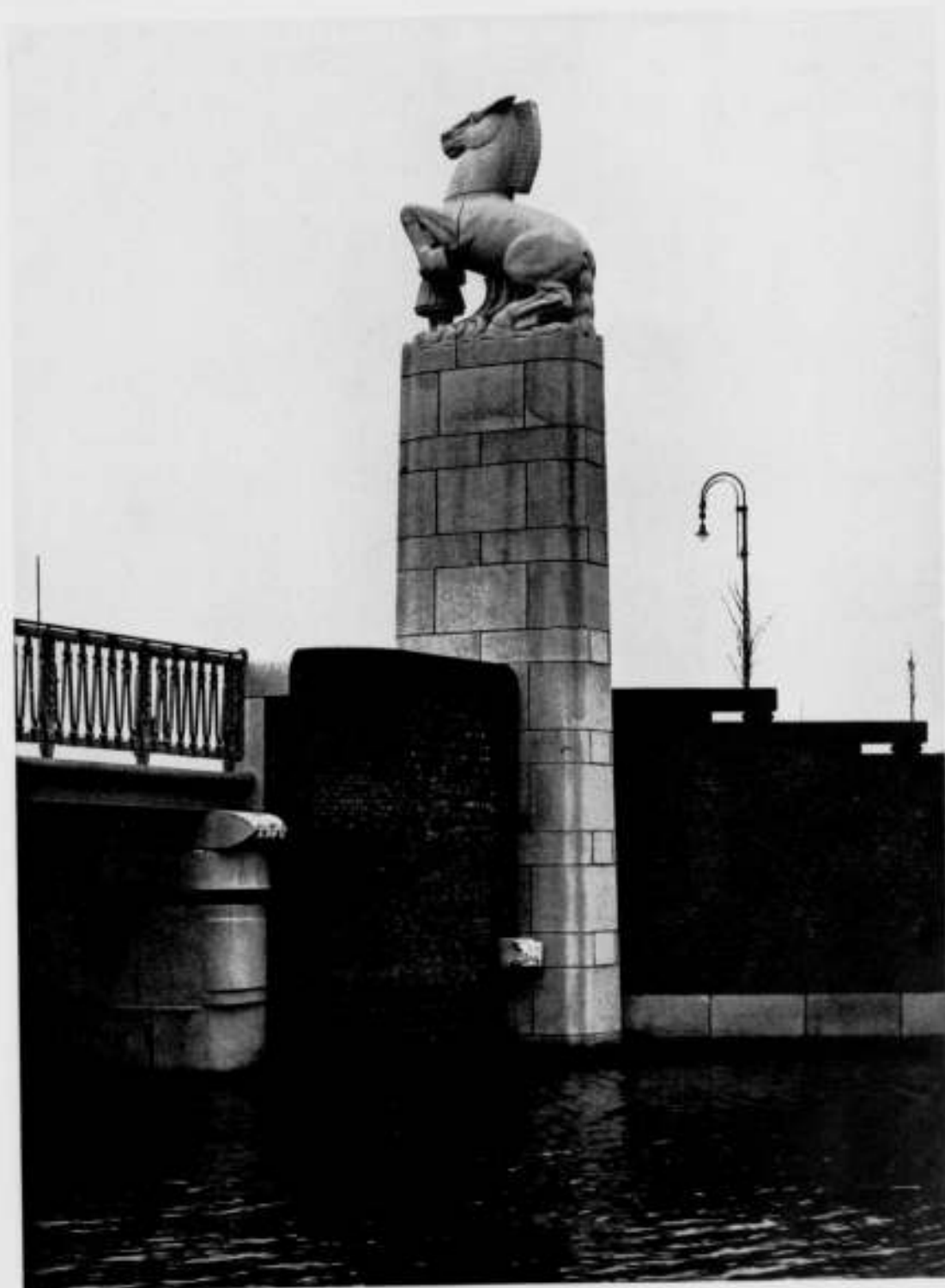
BRUGPYLOON. GRANIET. BOERENWETERING, AMSTERDAM
