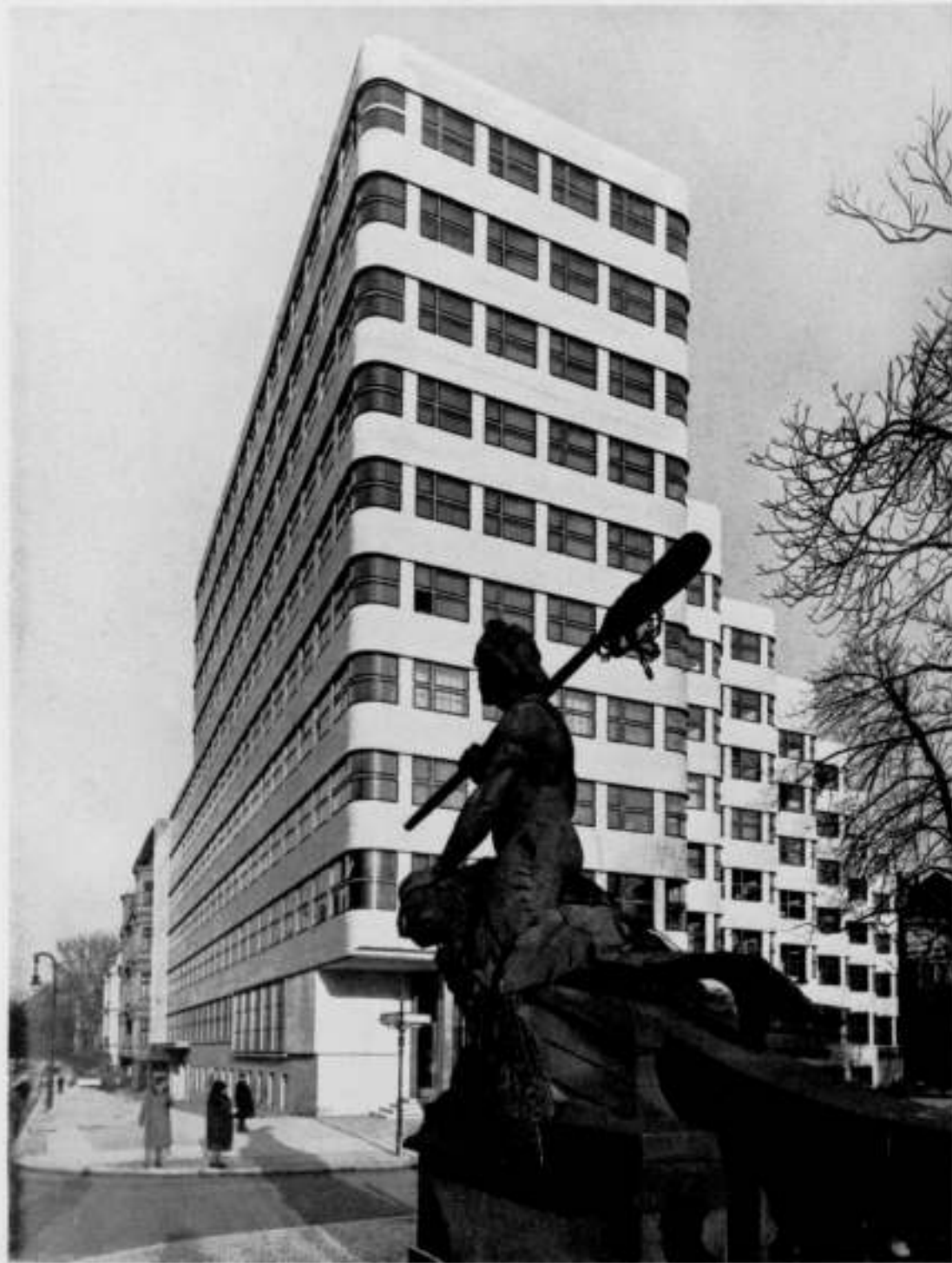
GEBOUW RHENANIA OSSAG (SHELLHAUS), BERLIJN
