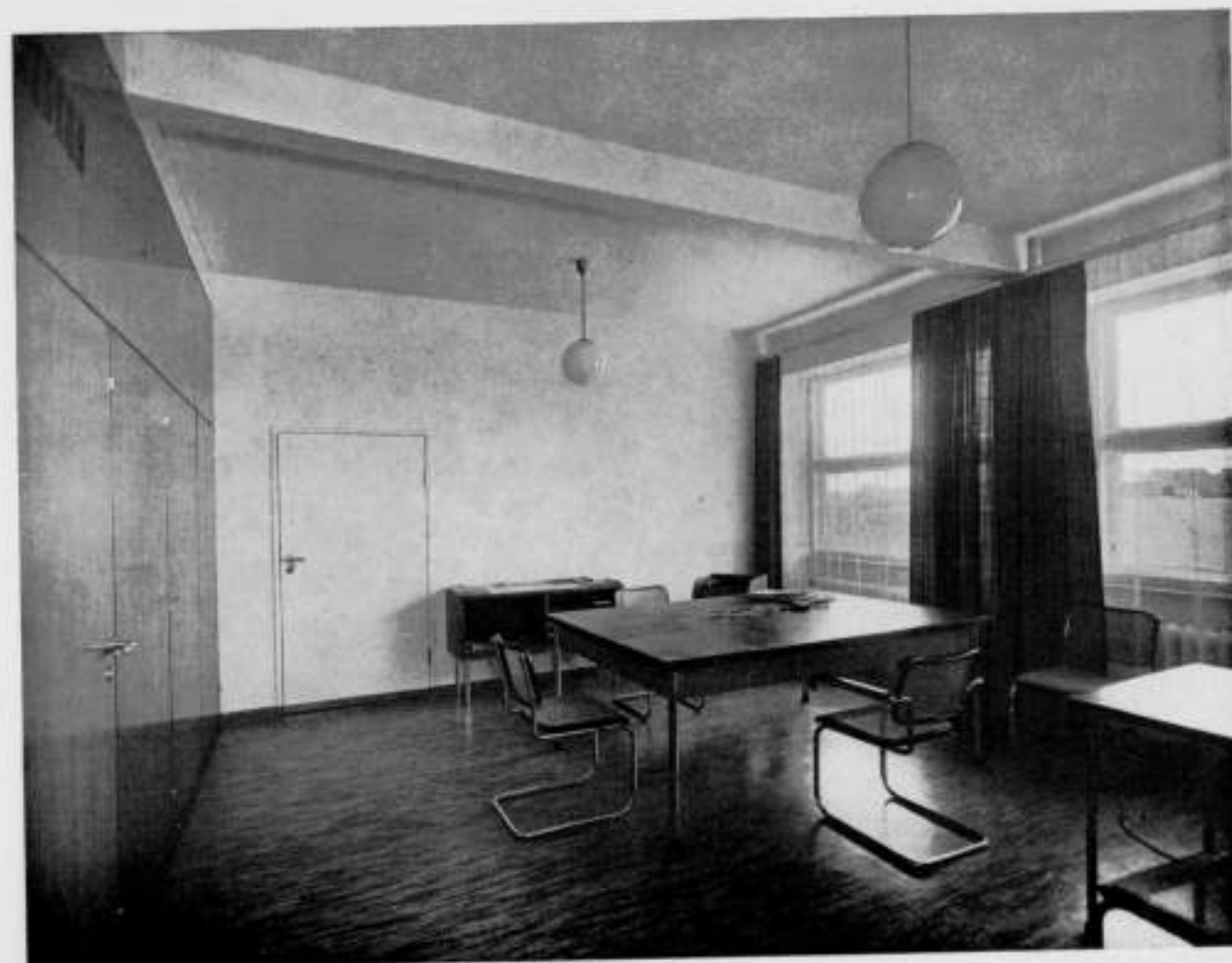
GEBOUW RHENANIA OSSAG (SHELLHAUS), BERLIJN
