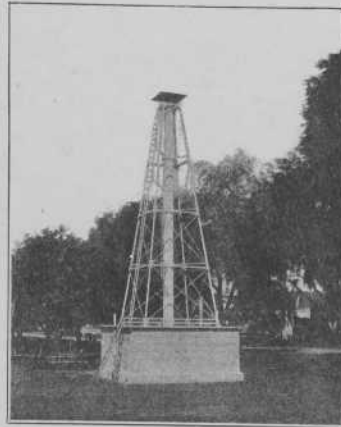
Standpijp te Tanah Abang
