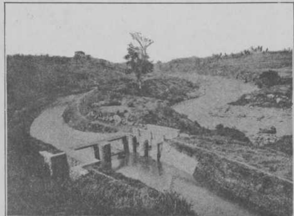
Spuisluis in de Progo-leiding.
