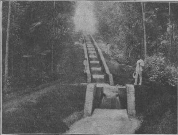
Gekoppelde stortdam der Patagoean-bevoeling.
