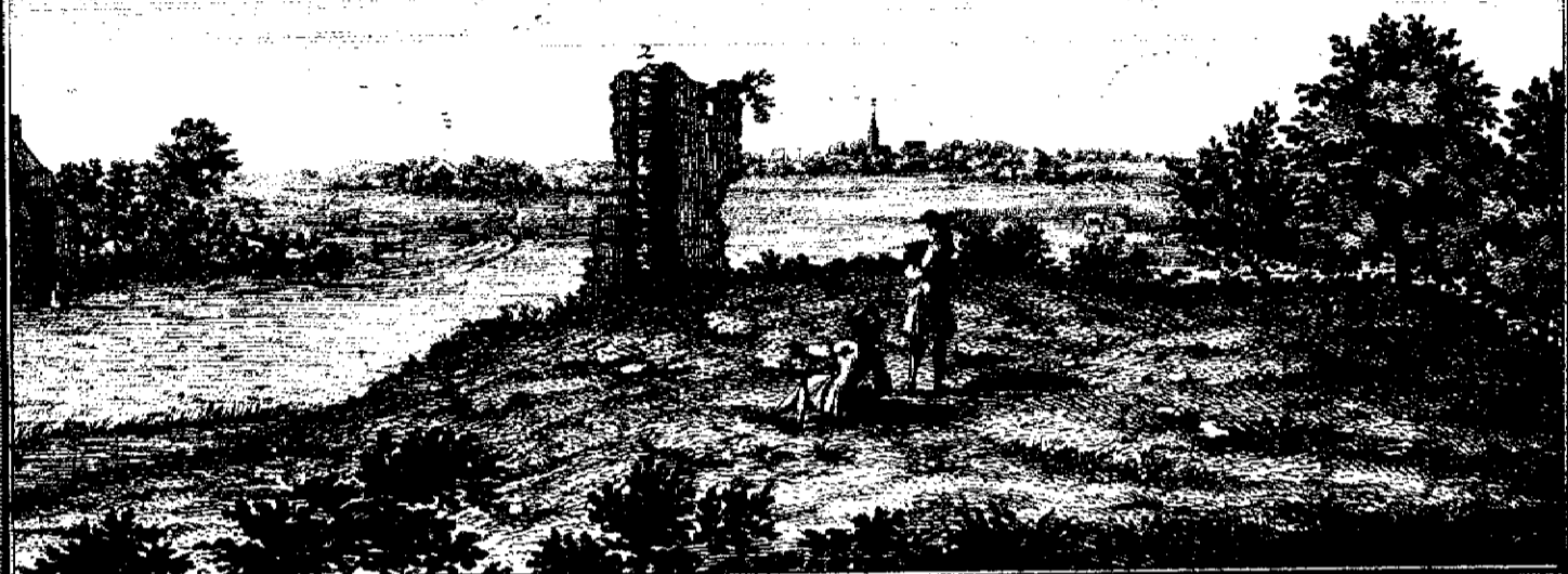
De (1) Grontslag en't (2) overgebleven Muurwerk van het Huis te Castricum of Crenobura in Kenneemerlant.
